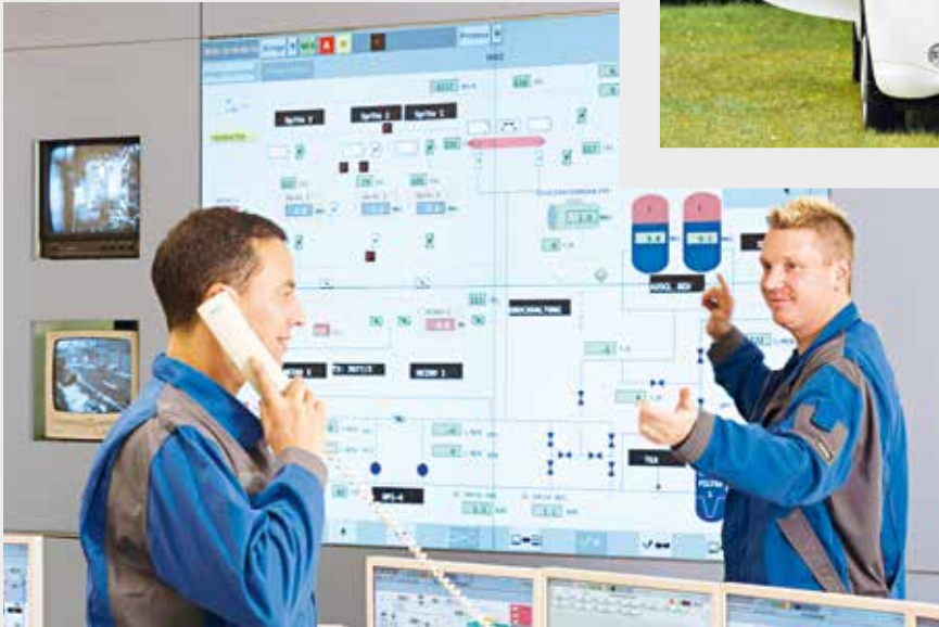
Die Stadtwerke Karlsruhe sind technisch.
