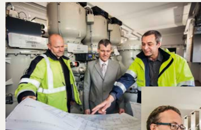
Dr. Heiko Hembach, Leiter Betrieb und Instandsetzung (Mitte), lässt sich von Projektleiter Achim Milbich (rechts) und Bauleiter Marco Belz die Pläne des Umspannwerks erläutern.
