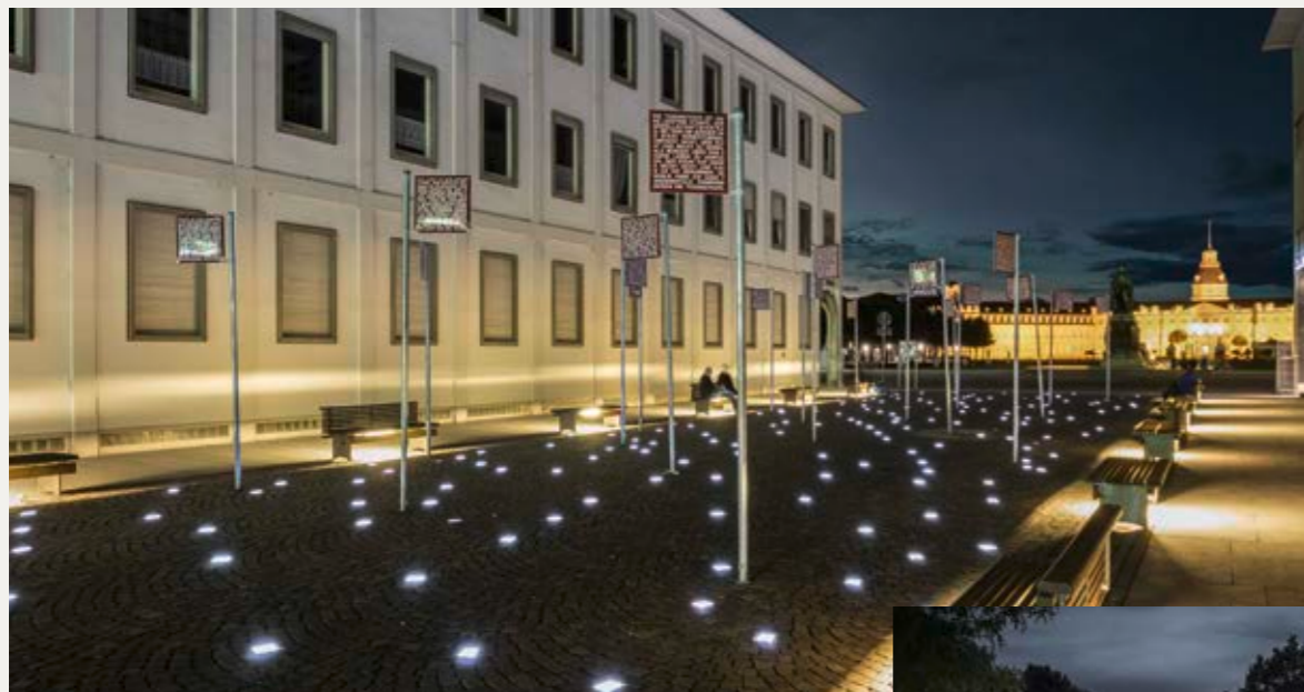
Der „Platz der Grundrechte“ – ein Geschenk der Stadt Karlsruhe an das hier ansässige Bundesverfassungsgericht – wird nachts von 500 LED-Leuchtsteinen mit über 2.500 weißen LEDs illuminiert.
