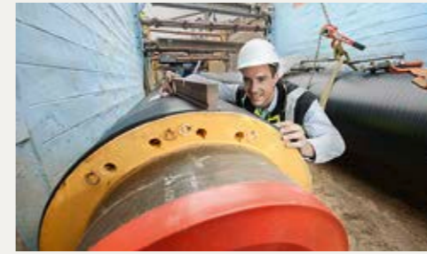
Die Stadtwerke bauen das Karlsruher Fernwärmenetz weiter aus.
