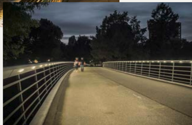
228 speziell gefertigte LED-Leuchten im Handlauf der Brücke über den Tiergarten sorgen für eine deutlich bessere Beleuchtung des Rad- und Fußweges.
