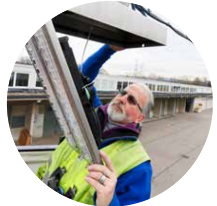
HEINZ HOFMANN kümmert sich an seinem luftigen Arbeitsplatz um Beleuchtungsanlagen.
