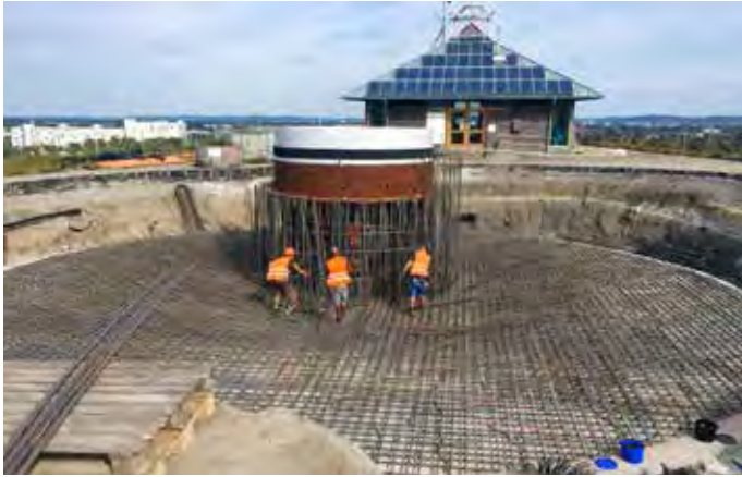
DAS FUNDAMENT der neuen Windkraftanlage hat einen Durchmesser von über 20 Metern.
