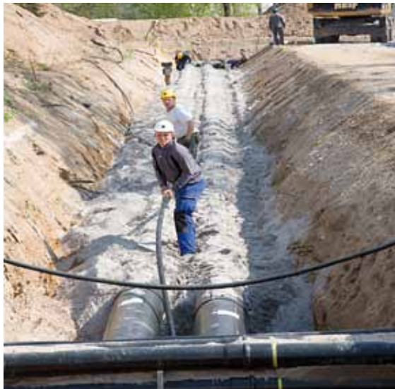
Bauarbeiten an der neuen Transportleitung zur Fernwärmeversorgung Nord.
