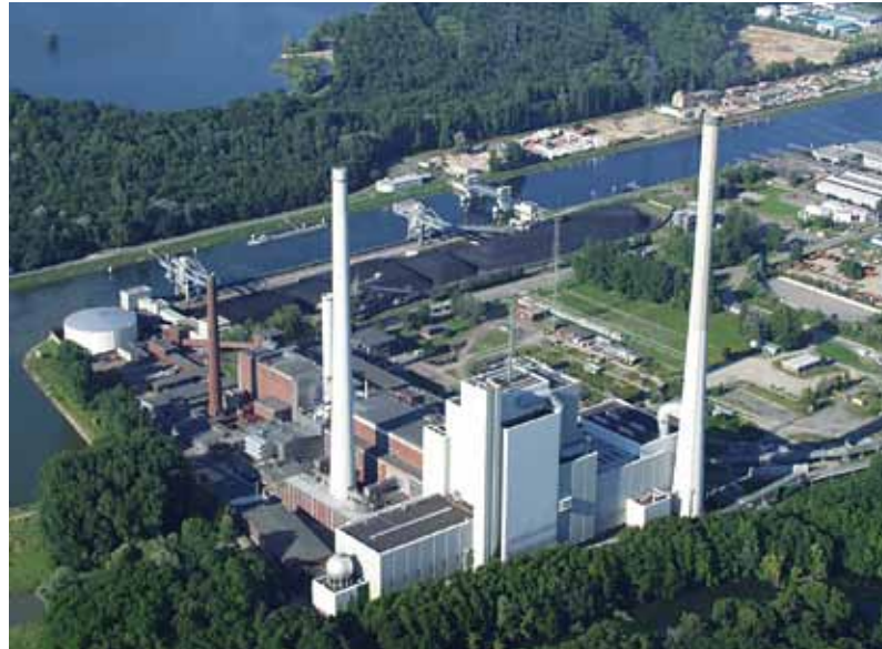
Rheinhafendampfkraftwerk (RDK) im Rheinhafen Karlsruhe.
