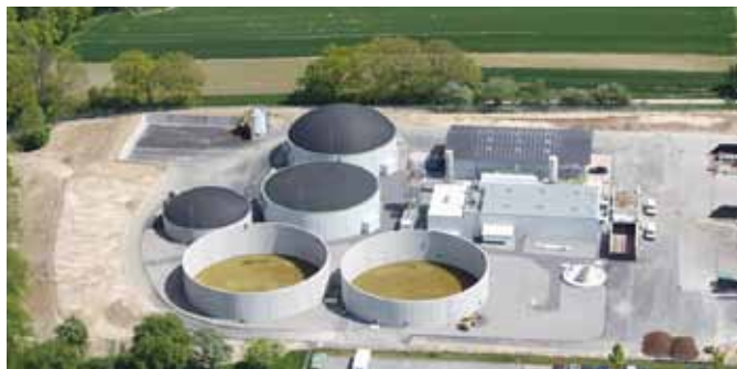
Anlage zur Biogasproduktion der Firma Biomethan in Mühlacker.
