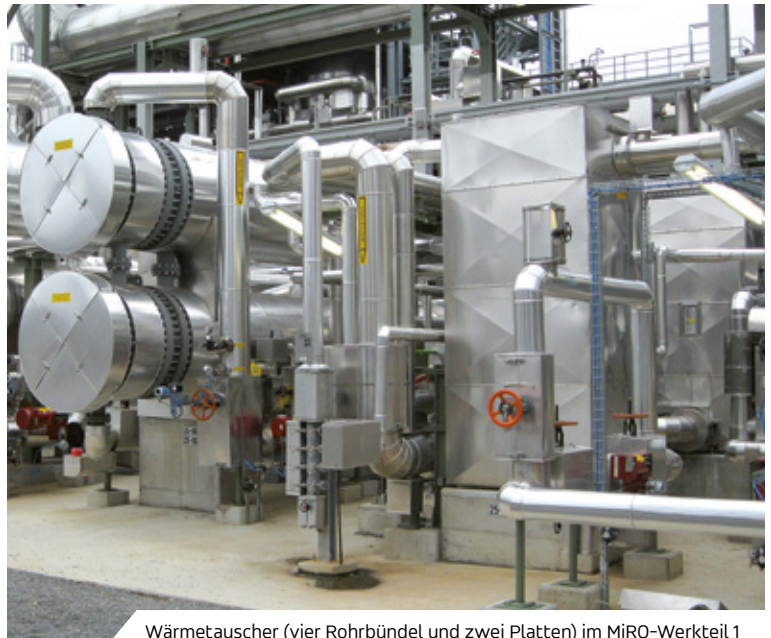
Wärmetauscher (vier Rohrbündel und zwei Platten) im MiRO-Werke teil 1 (Quelle: MiRO)
