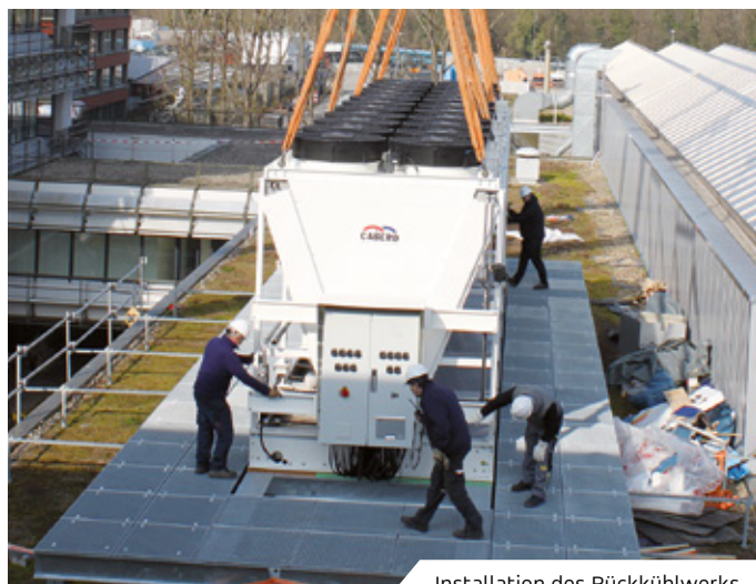
Installation des Rückkühlwerks
